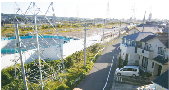
神領非常口の工事現場（左側）。住宅地（右側）に隣接している。
