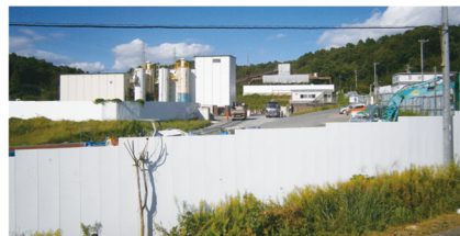
西尾非常口の工事現場
