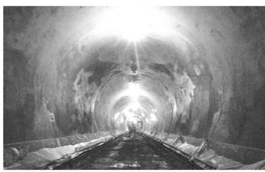
設楽ダムの本体工事ができるように豊川の流れを迂回させる仮排水路をつくる「転流工」＝国土交通省設楽ダム工事事務所「設楽ダムだより」2019年10月号より
