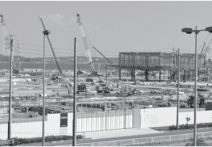
愛知県国際展示場建設予定地＝2月23日、常滑市・中部国際空港鳥
