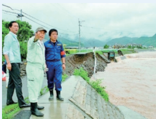
(写真) 花月川の護岸崩落現場を調査する仁比氏(右端)ら=6日、大分県日田市
