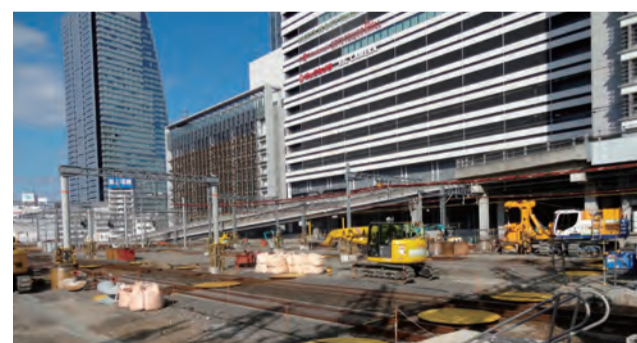
JR名古屋駅ではリニアの地下駅工事が進み、周辺の開削工事や名古屋城南の非常口工事など、膨大な掘削土砂の運搬による影響が心配されています。
